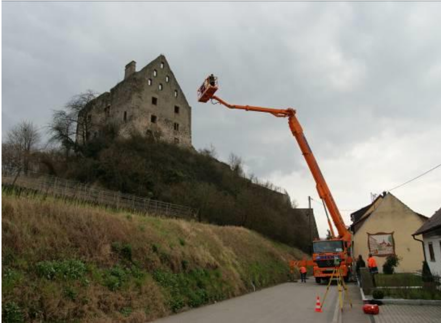
Abb. 19 : Aufnahme der Giebelwand der Burgruine von außen mittels Hubwagen
